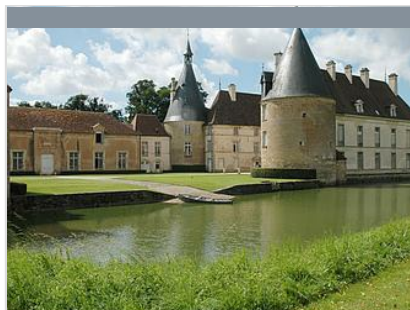
Boucle locale en espace partagé : Château de Commarin
